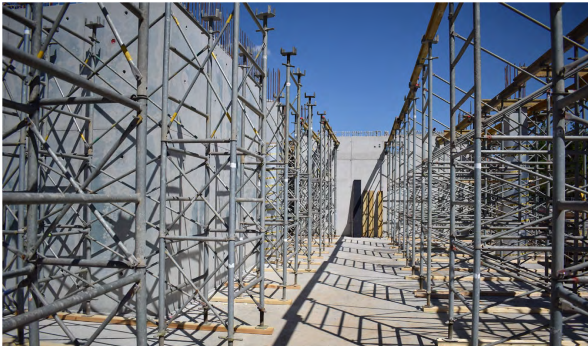
De onder stempeling staat alvast klaar voor de breedplaatvloeren van de 2 e deel van de 1 e verdieping.
