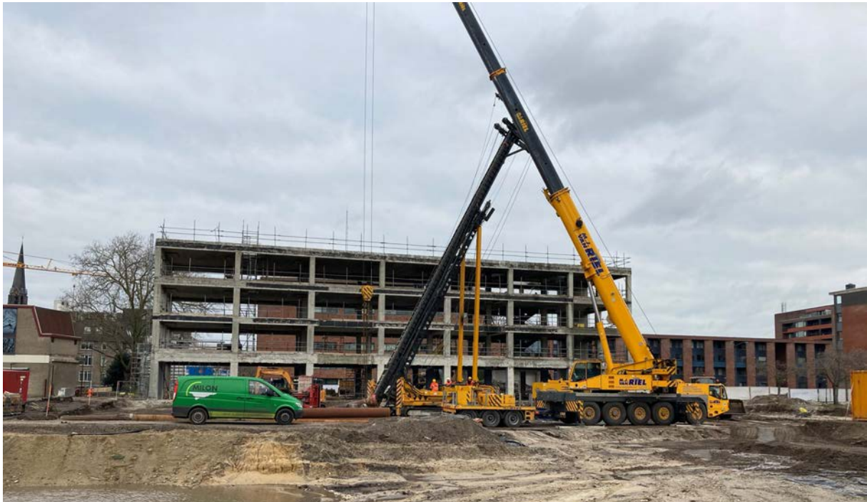
Hier ziet u de opbouw van de stelling voor de fundexpalen.
